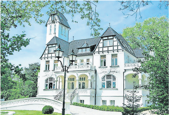
2007 hat Olav Killinger die Villa seines Urgroßvaters in Familienbesitz zurückgeholt und denkmalgerecht saniert. Inzwischen finden dort Konzerte, Hochzeiten und Seminare statt. FOTO: HARTMUT KLONOWSKI
